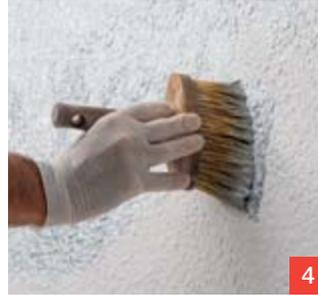
den ersten Auftrag mit GreoColor Lasur mit Metalliceffekt in Kreuzschlagtechnik mit einem Flächenstreicher oder einer Lasurbürste auftragen. Lasur mit Metalliceffekt je nach Wunsch mit Wasser verdünnen.
