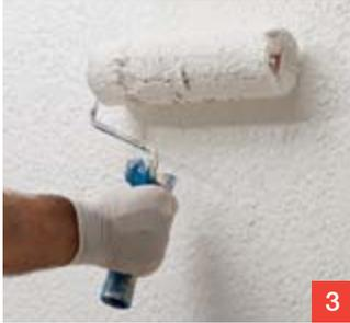
Anschliessend wird der Untergrund mit GreoColor NormaStar ein- bis zweimal (für den Innenbereich) oder mit GreoColor OptiSilc (für den Aussenbereich) zweimal hell gestrichen.
