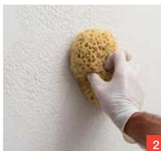
Den noch frischen Mörtel mit einem synthetischen Schwamm (Naturschwammschwamm) bearbeiten, indem man damit die Oberfläche abtupft. Mehr Druck ergibt eine gröbere Struktur. Schwamm regelmässig in sauberem Wasser reinigen.
